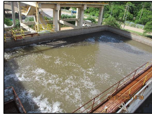
ภาพที่ 2.10 Equalization Tank
