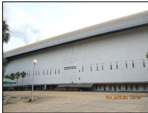
ภาพที่ 2.58 การออกแบบอาคารเป็นอาคารปิด เพื่อป้องกันเสียงดังออกสู่ภายนอกโครงการ
