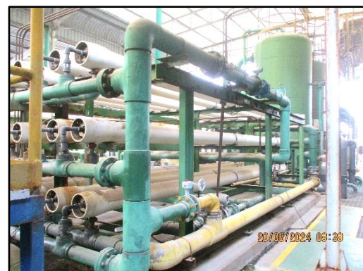
ภาพที่ 2.13 ระบบรวบรวมน้ำเสียจากระบบผลิตน้ำ ปราศจากแร่ธาตุ
